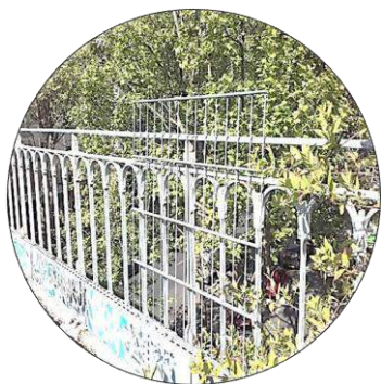
Mise au normes du garde corps historique existant par ajout d'une serrurerie avec remplissage maille rectangulaire
