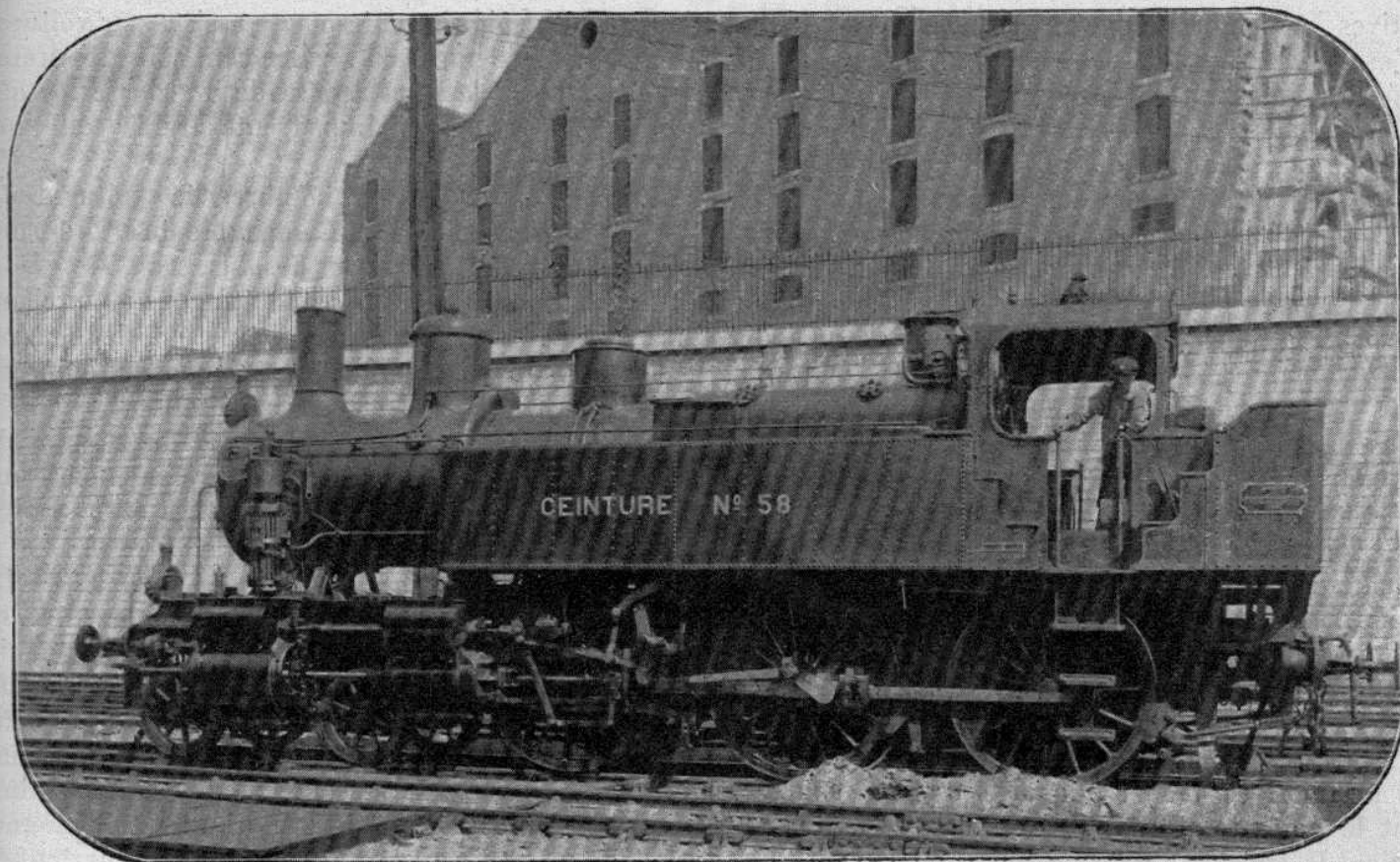
Fig. 2. — Locomotive-tender de la C ie du chemin de fer de Ceinture. Type 1902, compound à quatre cylindres, trois essieux couplés et un boggie.
